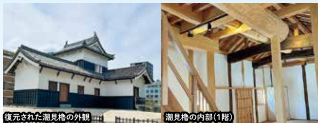
復元された潮見櫓の外観
